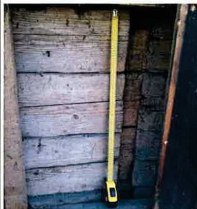
Ilustracja 42: Stosunkowo dobry stan zachowania belkowania ściany północnej. Widoczne niespasowanie połączeń zakładkowych w ścianie (zamknięcie pierwotnego otworu ściany północnej)
