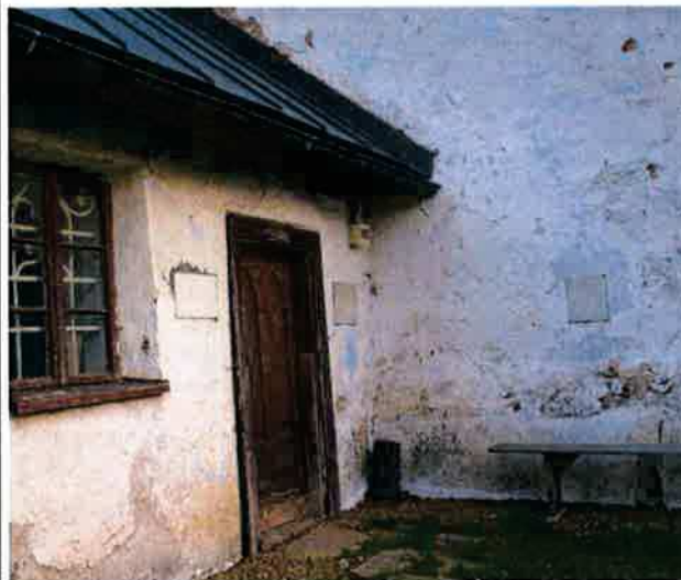
Ilustracja 70: Styk prezbiterium ze ścianą północną. Brak zauważalnego dylatowania się obu konstrukcji. Widoczne uszkodzenia powłoki malarskiej oraz miejscowo odparzenia tynku na obu ścianach
