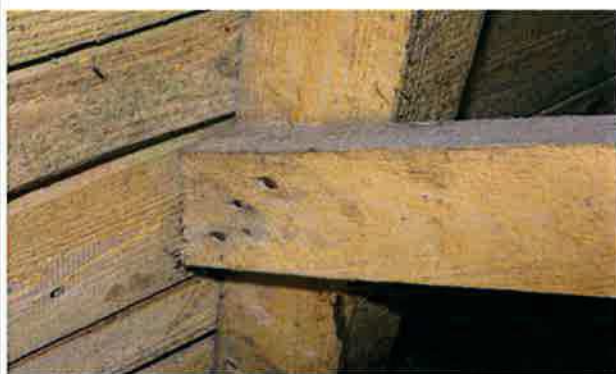
Ilustracja 15: Reprezentatywny schemat węzła, który z uwagi na poważne błędy wykonawcze oparcia na belkach ściennych stanowi główny układ utrzymujący więźbę w całości. Węzeł zbyt słaby, odległości łączników od krawędzi nie spełniają minimalnych wymogów. Taki układ węzła w obecnej więźbie zagrożony jest zniszczeniem
