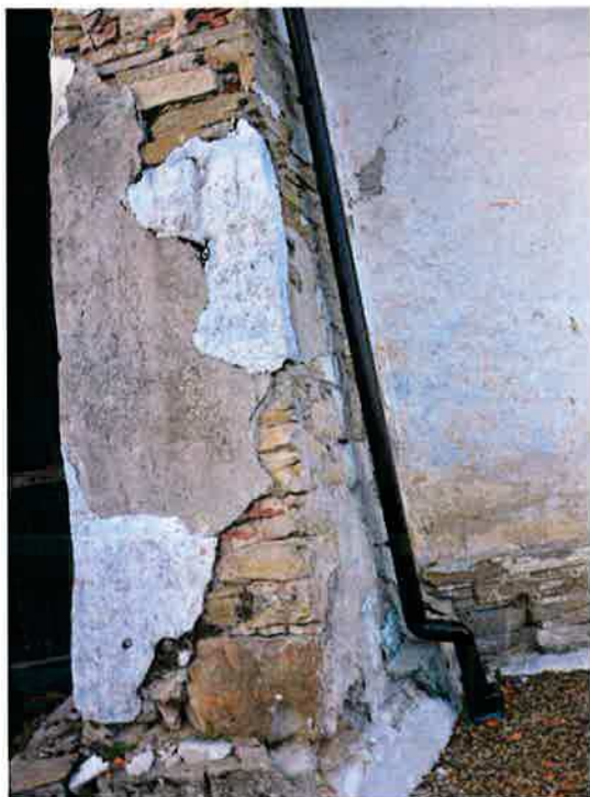
Ilustracja 59: Zniszczenie tynku na większości powierzchni przypory. Dobrze uwidocznione znaczne wypłukanie spoinowania w miejscu ekspozycji zaprawy wapiennej na środowisko zewnętrzne z uwagi na brak tynku.
