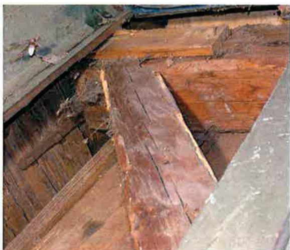
Ilustracja 49: Porażenie jednego ze zastrzałów ściany szkieletowej wschodniej kaplicy
