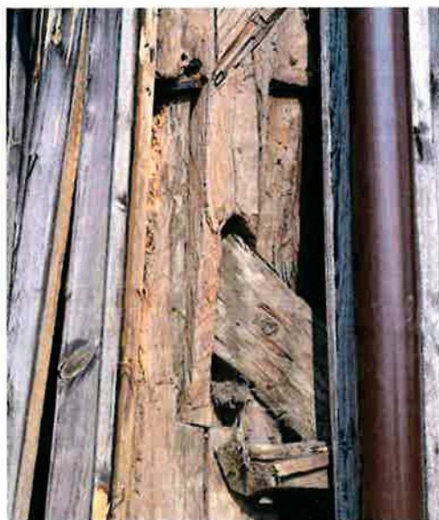
Ilustracja 2: połączenie wtórne zakładkowe podwójne (najprawdopodobniej wykonane przy wymianie dolnej partii słupa)
