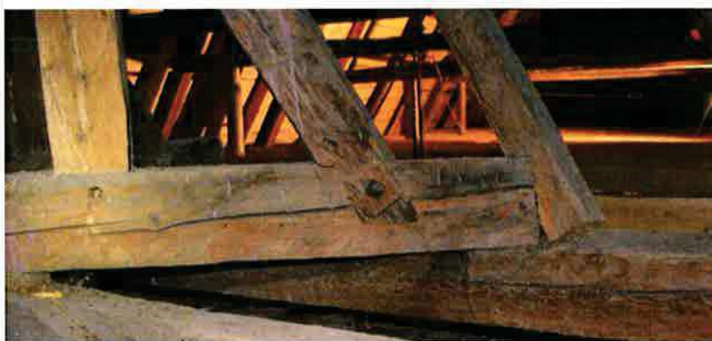
Ilustracja 81: Widoczny wymieniony słup - brak stabilizacji kołkiem. Stabilizacja połączenia ciesielskiego zastrzału z krzyżakiem przy użyciu śruby i podkładki drewnianej
