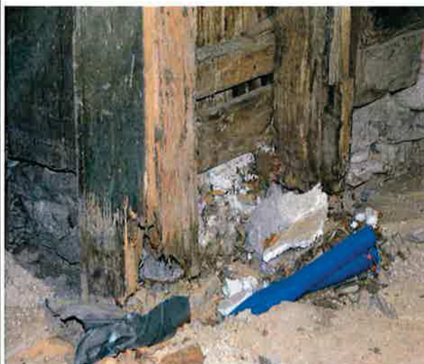
Ilustracja 48: Zniszczenie biologiczne podstawy słupa - narożnik ze ścianą wieńcową budynku
