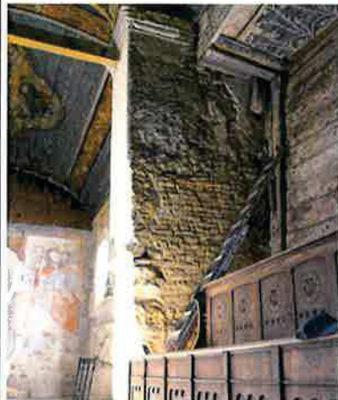
Ilustracja 72: Stan północnego fragmentu muru. Widoczne uzupełniania fragmentu muru cegłą oraz zaprawą c-w
