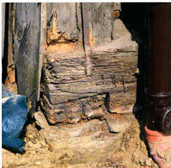
Ilustracja 1: Styk słupa główny - podwalina. Widoczna zaawansowane zniszczenie biologiczne drewna. Oparcie na fundamencie jest niestabilne oraz miejscowo bardziej podatne - stąd nie stanowi właściwego oparcia dla słupów głównych
