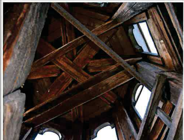
Ilustracja 10: Ogólny stan górnej partii sygnaturki. Dobry stan zachowania elementów konstrukcji
