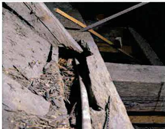
Ilustracja 17: Przed awaryjny stan belki zdwojonej, brak oparcia dwóch sąsiednich więźarów (strona wschodnia)
