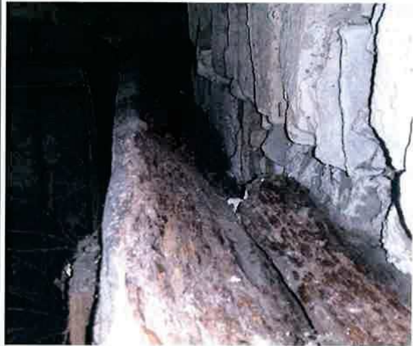
Ilustracja 54: Strona północna. Zniszczenie drewna Łątki (słupa skrajnego styku z murem) na płaszczyźnie styku z murem. Przyczyną takiego uszkodzenia jest brak izolacji i wentylacji styku oraz zwiększone zawilgocenie (prawdopodobnie wskutek miejscowego zaciekania w styku)
