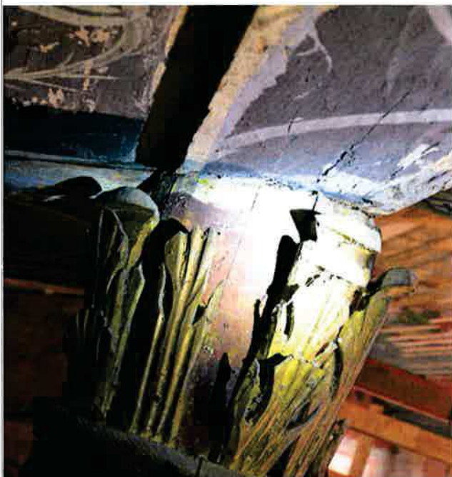
Ilustracja 38: Zmiazdzenie belki na głowicy słupa wskutek nierównomiernego docisku na powierzchni (skutek skręcenia belki północnej)
