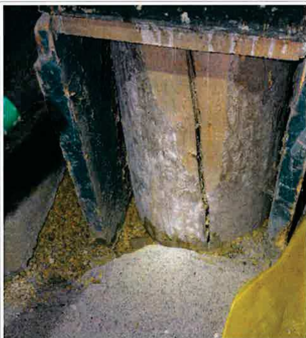
Ilustracja 40: Zawilgocenie podstawy słupa od strony północnej. Widoczne podciąganie wzdłuż drewna
