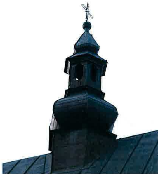
Ilustracja 78: Prawidłowa geometria sygnaturki. Nie zauważono nadmiernego przechylenia bryły czy też samej makówki mogących wskazywać na stan przedawaryjny konstrukcji drewnianej
