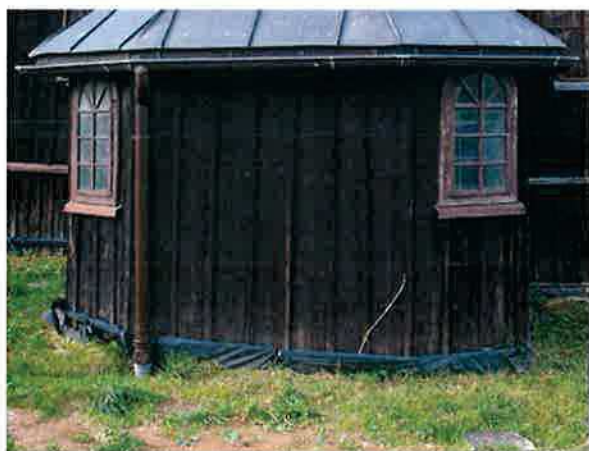
Ilustracja 51: Zakrycie folią i poziom terenu ponad poziom podwaliny powoduje jej ustawiczne zawilgocenie i niszczenie
