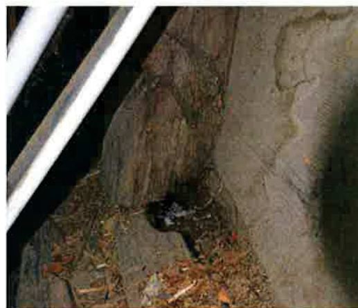
Ilustracja 27: Zniszczenie wrębu, brak oparcia ramy stolcowej w miejscu zniszczenia murłaty wskutek występowania zacieku - murłata ściany północnej murowanej
