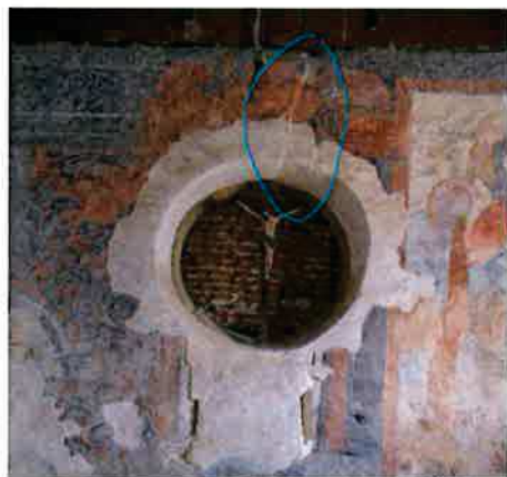
Ilustracja 63: Dawne uszkodzenie nad otworem ściany. Widoczne przemieszczenie odcinkowych obramowań otworu. W momencie wykonywania ekspertyzy – stan ustabilizowany
