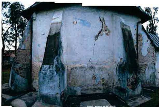
Ilustracja 61: Panorama ściany. Widoczna szczelina przebiegająca wzdłuż jednej z krawędzi zasklepionego otworu. Widoczny zły stan tynku wapiennego na przyporach oraz poziome przy terenie
