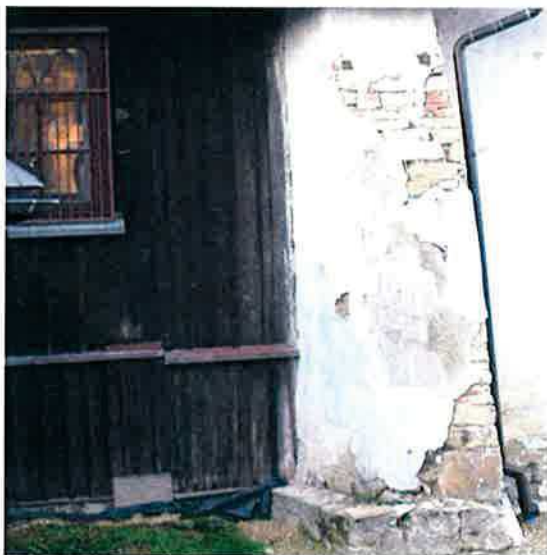
Ilustracja 55: Połączenie od strony południowej - po zdjęciu skrajnego deskowania na ogół w dostatecznym stanie
