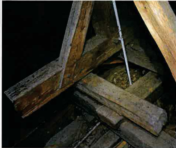
Ilustracja 30: Konstrukcja niwelująca poziom ułożenia krzyżaka na stropie
