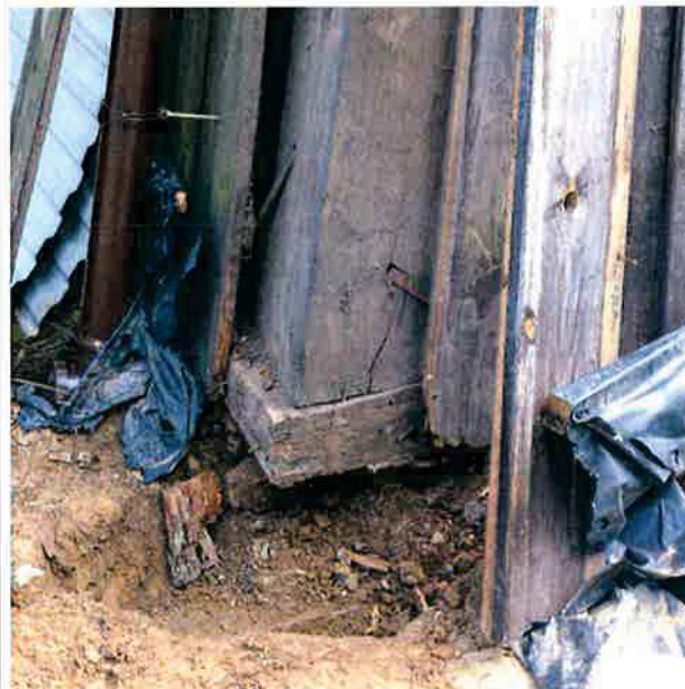
Ilustracja 4: Brak oparcia drugiego słupa głównego od frontu - widoczne wypadające fragmenty podwaliny wskutek zaawansowanego zniszczenia biologicznego spowodowanego bezpośrednim stykiem drewna z gruntem - słup "wisi" w powietrzu. Poniżej wykonano mikropal, jednak bez podparcia podwaliny
