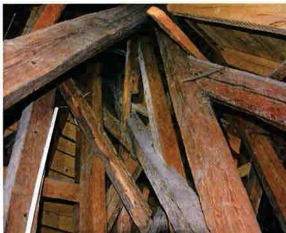
Ilustracja 80: Splątanie węzłów. Widoczne nadmierne wycięcia zastrzałów konstrukcji spowodowane problemem z kolizją
