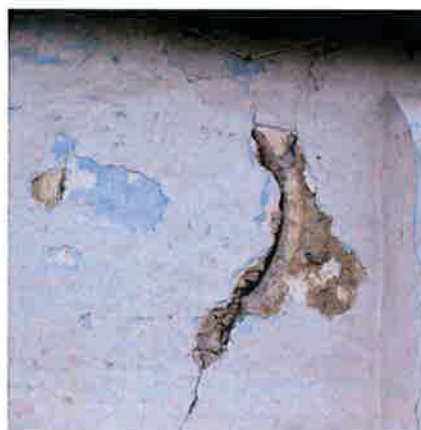
Ilustracja 66: Wypadanie murowania otworu. Widoczna szczelina na ścianie zewnętrznej przebiegająca na jej wysokości, sięgająca murłaty
