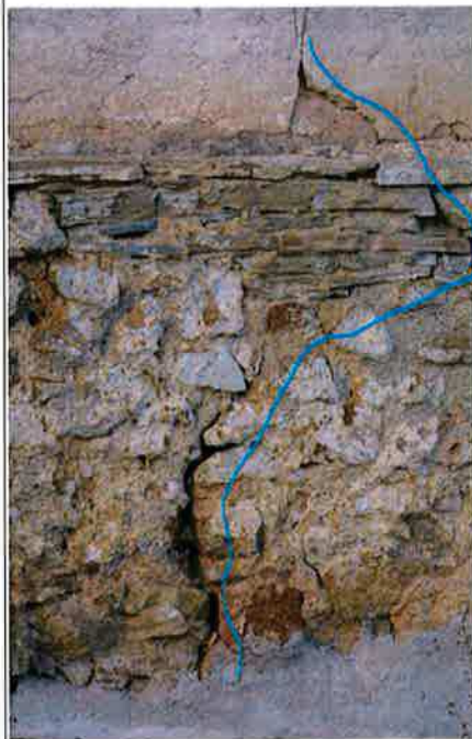
Ilustracja 60: Przebieg szczeliny na wysokości ściany fundamentowej. Pęknięcie wzdłuż najsłabszego przekroju. Omawiane pęknięcia są skutkiem nierównomiernego osiadania budynku, a ich charakter na czas wykonywania ekspertyzy jest nieustabilizowany z uwagi na pojawiające się zarysowanie nadproża łukowego wewnątrz budynku (po niedawnej renowacji tynku)
