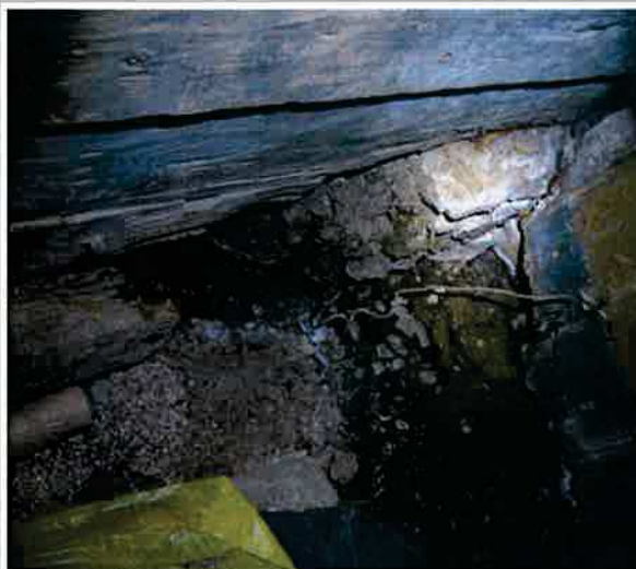
Ilustracja 46: Odcinek cokołu kamiennego przy narożniku północno-wschodnim nawy. Widoczne zniszczenie belki oraz jej wypadnięcie
