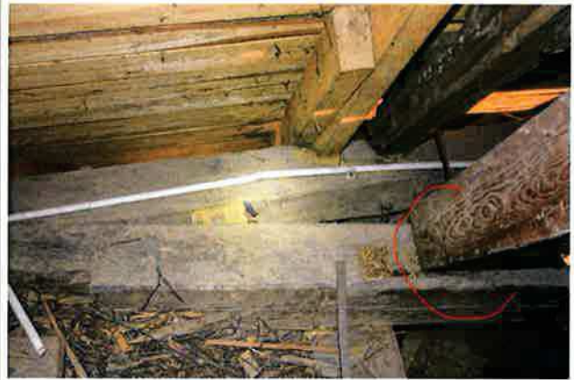
Ilustracja 31: Sposób oparcia na murze (strona południowa) - krokiew na murłacie łączenie poprzez wręb. Murłata wstępnie zabezpieczona przed obrotem i przesunięciem poprzez strzemie stalowe, wymaga jednak korekty w kierunku stabilizacji . Element wtórnie wbudowany jako murłata – widoczna konstrukcja wsporcza sygnaturki została wykonano po generalnej przebudowie sygnaturki.
