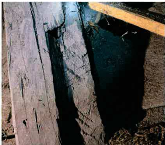
Ilustracja 23: Spaczenie części połączeń na jaskółczy ogon między zastrzałem a stolcem pochyłym. Niebezpieczeństwo wypadnięcia z węzła
