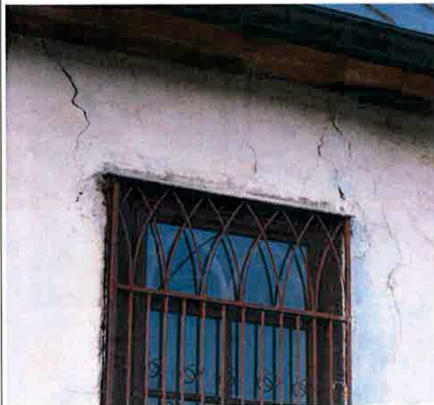
Ilustracja 58: Zarysowanie w przęśle nadproża oraz krawędziach (otwór wschodni)
