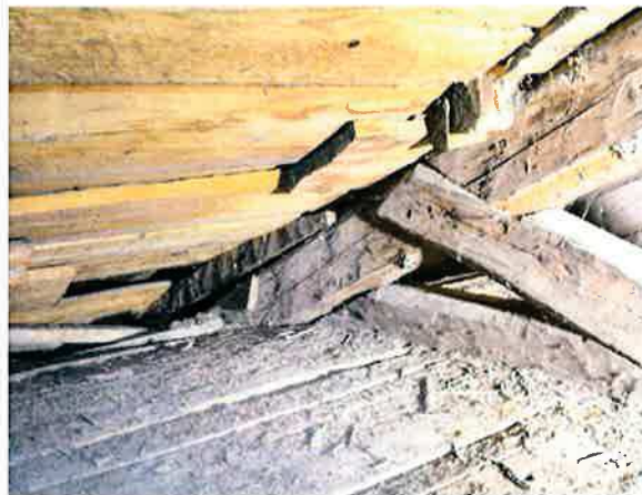
Ilustracja 244: Wiązar o znacznie zredukowanym przekroju w rozpiętości rygla. Próba wzmocnienia poprzez prowizoryczną nadbitkę. Przekrój zbyt zredukowany, aby zapewnić odpowiednią nośność
