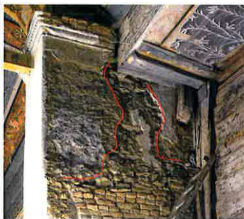
Ilustracja 74: Szczeliny widoczne w fragmencie południowym. Możliwe, że związane z wykonaniem podkopu krypt. Widoczne uszkodzenie ściany wraz ze słabym spoinowaniem oraz fragmentarycznych braków (uzupełnianych) obniża znacznie wytrzymałość muru na ściskanie pod oparciem belki zdwojonej. Widoczny stan uszkodzenia muru bez naprawy prowadzić będzie do pogłębienia uszkodzeń wskutek docisku belki na osłabiony mur. W chwili obecnej mur nie stanowi prawidłowego oparcia dla belki zdwojonej
