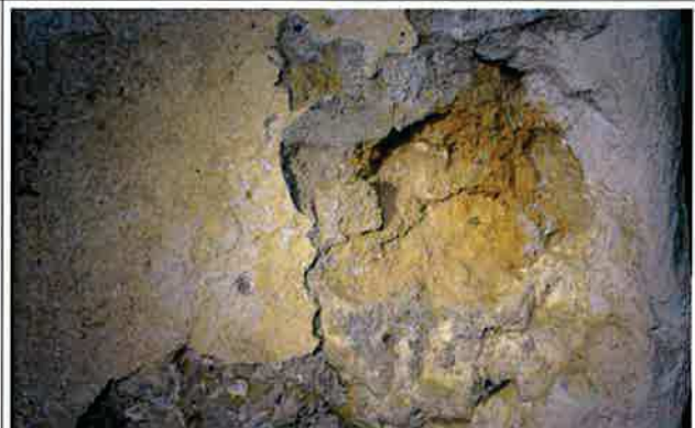
Ilustracja 76: stan tynku ściany od strony wewnętrznej. Widoczne odparzanie tynku (prawdopodobnie na glinie) i przekrój przez uwarstwienie
