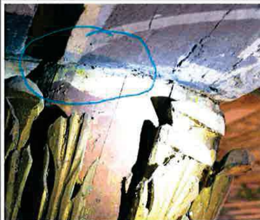
Ilustracja 22: Zmiazdzenie drewna w miejscu oparcia belki zdwojonej na słupie drewnianym. Widoczne nierównomierne, skręcone oparcie na słupie
