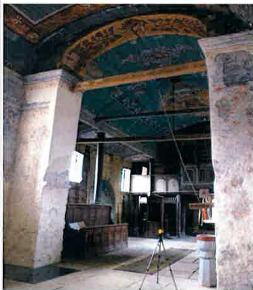
Ilustracja 73: Stan po renowacji powierzchni ścian od strony wschodniej. Nie stwierdzono nowego zarysowania w trakcie prowadzenia oględzin po renowacji ścian od strony wschodniej
