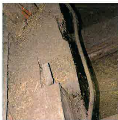
Ilustracja 20: Widok od góry na przegub w przeszle. Z powodu niezajomości pracy belki przy zadanym schemacie wykonano nieprawidłowe "wzmocnienie" poprzez wbicie klina pogarszającego złą sytuację konstrukcji.
