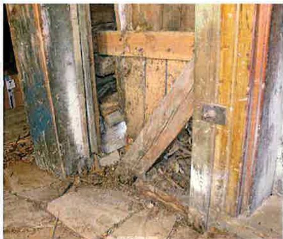
Ilustracja 47: Zniszczenie podwaliny oraz dolnych odcinków przywęzłowych zastrzałów i słupów
