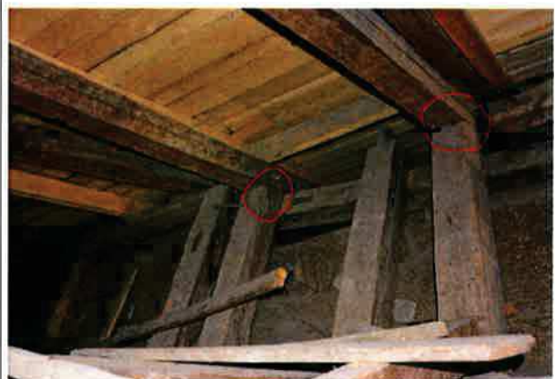
Ilustracja 37: Belki wspierające konstrukcję. Zrealizowana dwa typy oparcia. 1. Oznaczony na czerwono opierany na dawnych krokwiach poprzez czop prosty. 2. Grawitacyjnie na belce poprzecznej układanej na ramie stolcowej sklepienia - strona południowa
