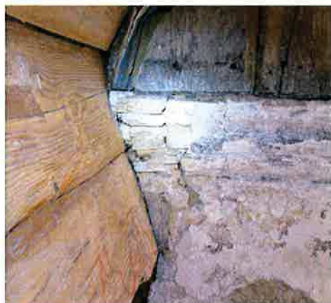
Ilustracja 21: Widoczne uzupełnienia muru związane ze zmianą geometrii więzara (skręceniem).
