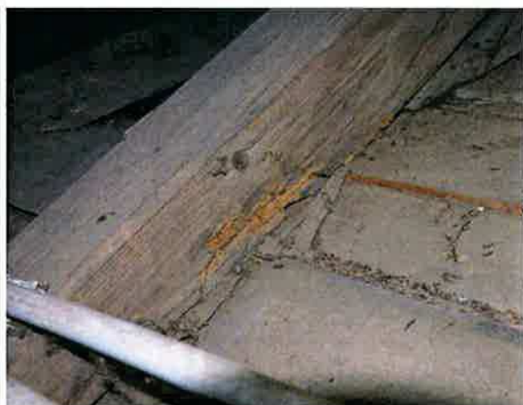
Ilustracja 26: Uwidoczniona korozja biologiczna jednej z ram Ilustracja 25: Uwidoczniona korozja biologiczna jednej z ram stolcowych
