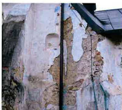
Ilustracja 65: Widoczne wypłukanie zaprawy spoinowania między elementami murowymi. Tynk na znacznej powierzchni bez przyczepności - odpada płatami. Spoinowanie bez odpowiedniego zabezpieczenia względem środowiska zewnętrznego ulega przyspieszonej degradacji
