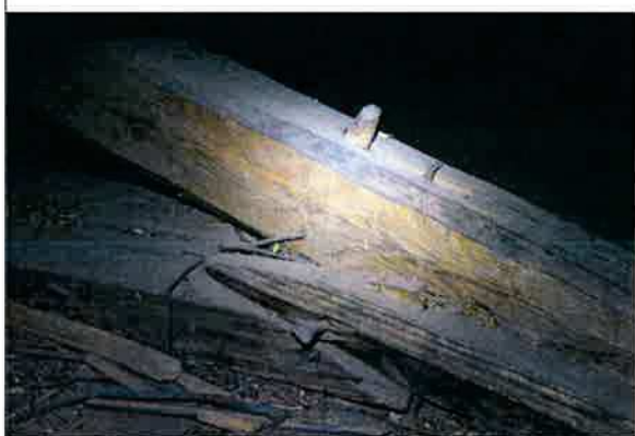
Ilustracja 27: Próba wzmocnienia odcinka stolca pod zastrzałem (wiązar niosący część ciężaru sygnaturki). Widoczne przemieszczenie kołka wskutek występowania znacznych sił w węźle
