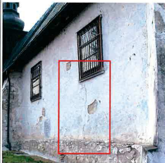
Ilustracja 62: Zarysowanie pod otworem okiennym nawy strony południowej
