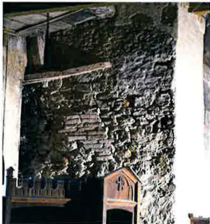
Ilustracja 71: Stan północnego fragmentu muru. Widoczne uzupełniania fragmentu muru cegłą oraz zaprawą c-w
