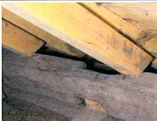
Ilustracja 14: Nieprawidłowe wykonanie oparcia krokwi na ścianie wieńcowej. Nieprawidłowy schemat może spowodować zmiążdżenie drewna belki lub w przypadku znacznego ssania wiatru - poderwanie dachu przy okapie
