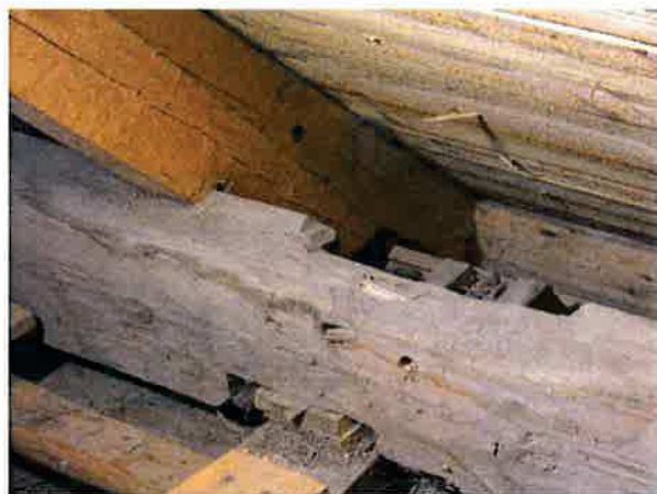
Ilustracja 45: Próba niwelacji belki górnej. Wykonano prowizoryczne klinowanie i rozłączenie belki skrajnej od ściany
