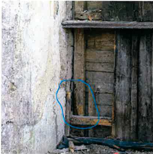
Ilustracja 53: Zniszczenie słupka rusztu i fragmentu belkowania ściany na styku z przyporą (strona północna).
