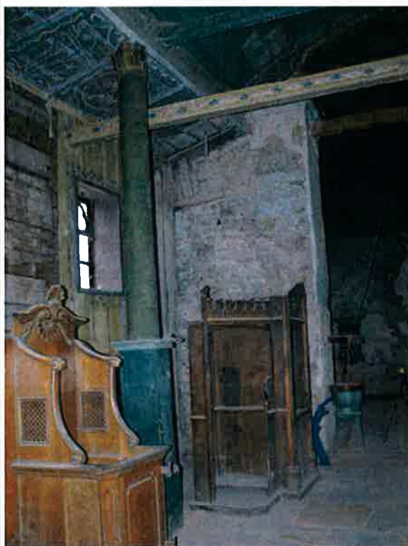
Ilustracja 39: Forma słupa. Dołem obudowa ze skrzynki drewnianej. Podparcie słupa na docisk od czoła, bez łącznika.
