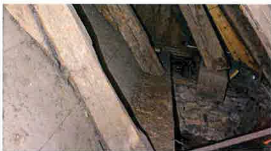
Ilustracja 75: Góra ściany fragmentu południowego. Widoczne oparcie belki zdwojonej (centralna) oraz podwaliny pod ramę sygnaturki (zewnętrzna)
