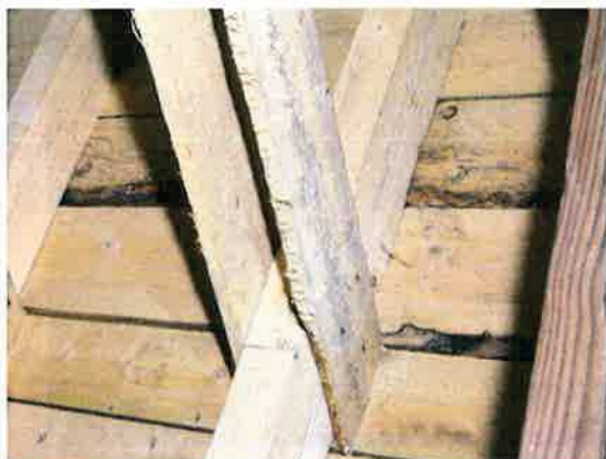
Ilustracja 11: Użycie na więźbę drewna nieprawidłowo obrobionego, o nieznannej wytrzymałości. Widoczne ślady po traku. Deskowanie z widocznymi miejscami porażenia przez grzyb
