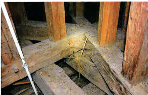
Ilustracja 79: Krzyżak dolny jako wsparcie słupów, służący rozłożeniu obciążenia na belkowanie. Stan dobry
