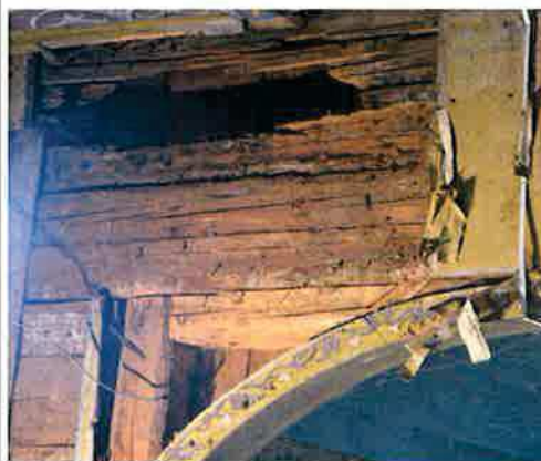
Ilustracja 44: Zniszczenie belkowania ściany od strony północnej. Stan przed awaryjny konstrukcji
