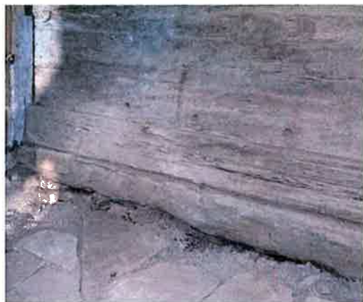
Ilustracja 41: Postępujące zniszczenie biologiczne przekroju na styku z gruntem – ściana zachodnia (dzieląca od dzwonnicy). Postępujące uszkodzenie pierwszej belki prowadzić będzie do osiadania ściany na długości, a w pewnych warunkach może doprowadzić do utraty stateczności
