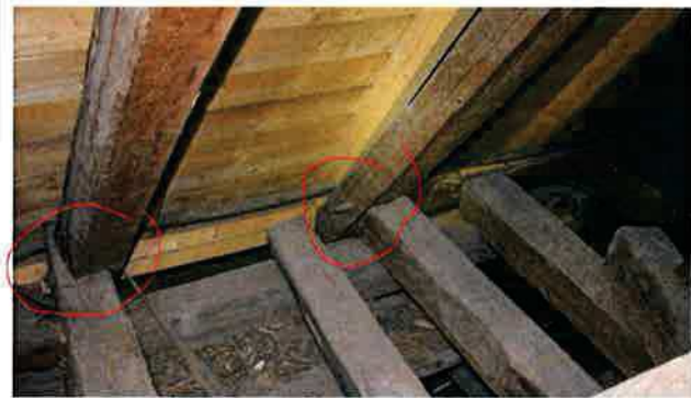
Ilustracja 32: Oslabiono przekrój kluczowych krokwi oraz dodatkowo dociężono przez jej nacięcie i ułożenie płatwi. Z tej strony także zrealizowano dwa typy oparcia, nieco inne. 1. Oznaczony na czerwono opierany na dawnych krokwiach poprzez wręb czołowy. 2. Grawitacyjnie na belce poprzecznej układanej na ramie stolcowej sklepienia - strona północna
