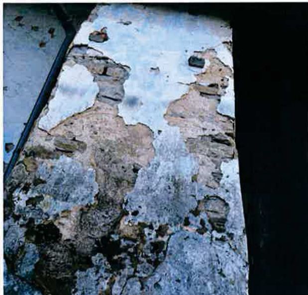
Ilustracja 68: Degradacja tynku na przyporze, brak przyczepności tynku do podłoża na znacznej powierzchni. Na powierzchniach pozbawionych tynku widoczne postępujące niszczenie zaprawy spoinowania
