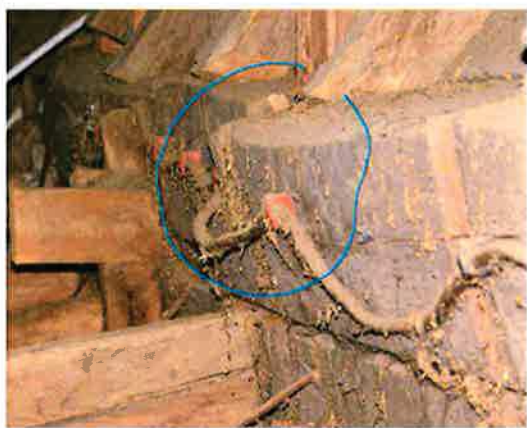
Ilustracja 19: Skręcenie belki zdwojonej północnej w miejscu błędu technologicznego – przerwania ciągłości
