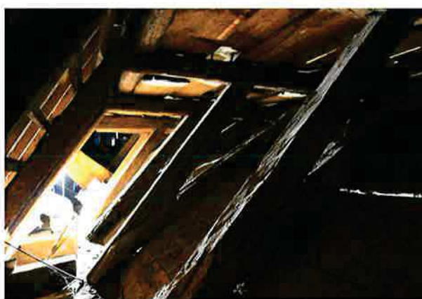
Ilustracja 28: Układ wiązarów i sposób zamontowania poprzez wręby w belce górnej
