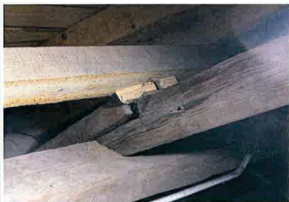
Ilustracja 13: Karygodny sposób oparcia pośredniego płatwi na historycznych krokwiach - układ stwarzający zagrożenie uszkodzeniem lub zniszczeniem części dachu
