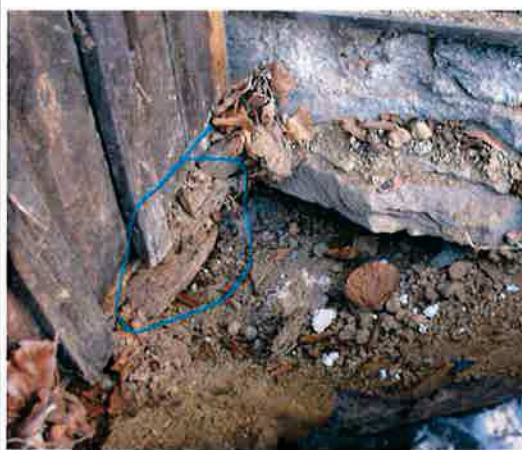
50: Butwienie podwaliny w gruncie - strona zewnętrzna. Zbyt wysoki poziom terenu wokół kaplicy – poziom terenu powyżej poziomu podwaliny
