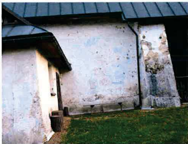
Ilustracja 67: Ściana północna. Widoczne odparzenia tynku na przyporze oraz dolny odcinek niegdyś uzupełniany zaprawą cementową
