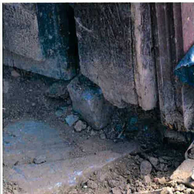
Ilustracja 3: Brak oparcia słupa przy wejściu do kościoła - widoczny kawałek czopa w miejscu gdzie pierwotnie ułożono próg drewniany
