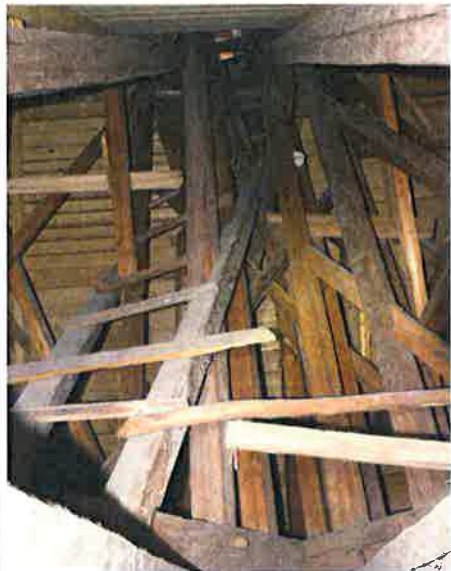
Ilustracja 77: Dolna część konstrukcji słupowo-zastrzałowej sygnaturki. Nie zauważono uszkodzeń lub przemieszczeń konstrukcji. Słupy na obwodzie zewnętrznym - prowadzone do poziomu hełmu. Słupy na obwodzie wewnętrznym prowadzone aż pod górny krzyżak (pod król). Słupy spięte przeciwległe zastrzałami rozpartymi na krzyżaku
