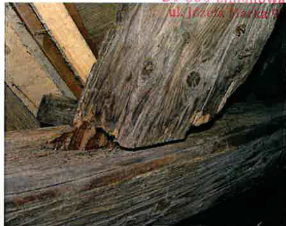
Ilustracja 6: Wygnicie połączenia krzyżowego zastrzałów ściany północnej - obecnie ze względu na zaawansowane korozję biologiczną elementy są rozłączone
