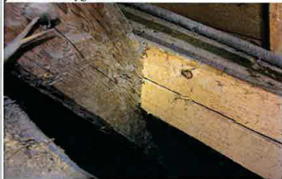
Ilustracja 32: Wycięcie krokwi przenoszącej część obciążenia sygnaturki (strona północna) - osłabienie kluczowego elementu konstrukcji. Wcięcie wykonano pod płatw w trakcie ostatniego remontu
