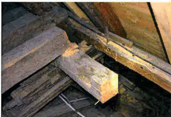
Ilustracja 34: Sposób oparcia poprzez belkę poprzeczną - strona północna. Wykonano niwelację poprzez nałożenie podkładki z przebudowanej konstrukcji. Elementy użyte
