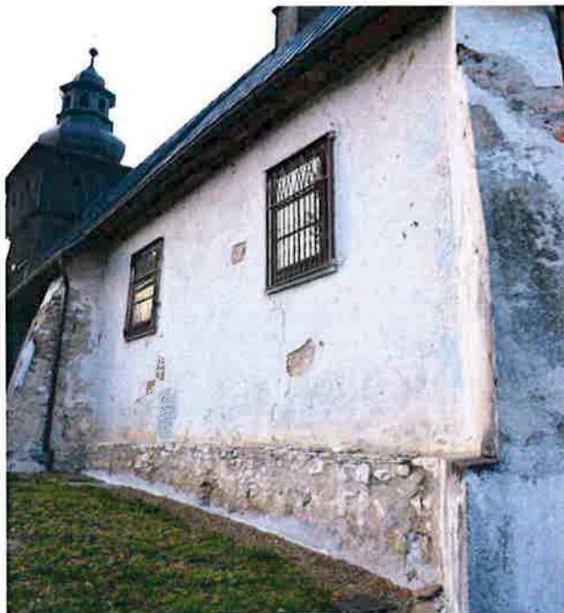
Ilustracja 57: Ogólny stan muru południowego. Widoczna degradacja tynku - odparzenia tynku (brak przyczepności). Widoczne zarysowanie ściany i nadproża przy otworze wschodnim
