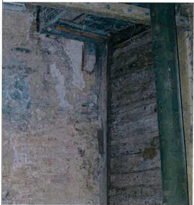
Ilustracja 56: Łątka i styk południowy. Widoczne miejscowo uszkodzenia drewna belkowania od czoła. Na ogół w stanie dostatecznym i lepszym niż styk północny
