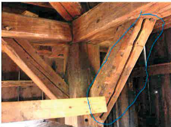
Ilustracja 7: Rozeschnięcia zastrzałów/mieczów zauważalne w poziomie izbicy oraz konstrukcji głównej - przechodzące na jaskółczy ogon wyłączają węzeł z pracy
