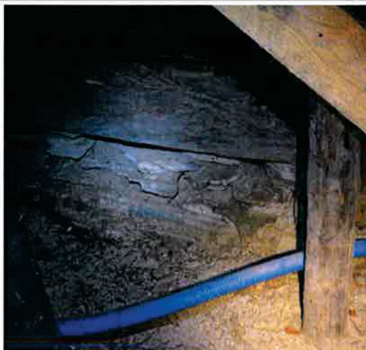
Ilustracja 52: Podniesienie cokołu, wtórne, wskutek wymiany za zniszczoną belkę podwalinową
