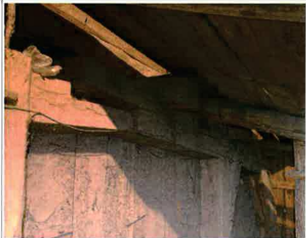
Ilustracja 8: Zniszczenie połączenia nakładkowego zlokalizowanego w konstrukcji ściany wschodniej. Skutek nierównomiernego osiadania konstrukcji, powodującej nieprawidłową pracę elementów skutkujących deformacjami i zniszczeniem niektórych elementów
