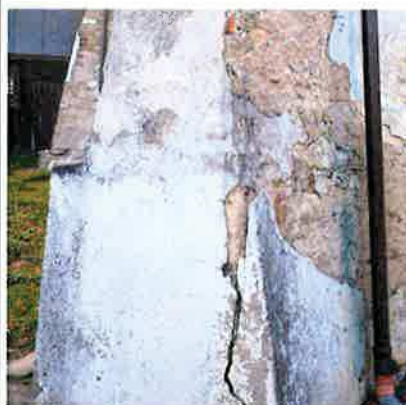
Ilustracja 64: Odpadanie tynku od przypór. Widoczne uszkodzenie zaprawy tynku oraz spoinowania. Wymaga kompleksowej renowacji spoinowania. Przypora południowa
