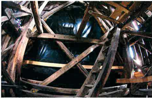
Ilustracja 5: Wnętrze dzwonnicy - folia zaciemniająca dla nietoperzy. Widoczny ogólnie na pierwszy rzut oka dobry stan zachowania konstrukcji drewnianej
