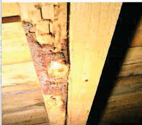
Ilustracja 12: Krokwie i deskowanie nieokorowane, przebarwione. Miejsca nieokorowane stanowią idealne środowisko dla owadów
