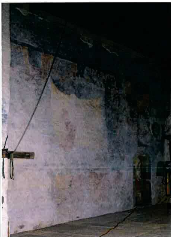
Ilustracja 69: Dobry stan zachowania ściany od strony wewnętrznej. Po remoncie brak śladów postępującego uszkodzenia, brak zarysowań
